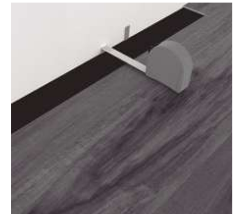
Paso 10: Última fila. El ancho mínimo de la última tabla no debe ser MENOR de 2" de ancho. Coloque un separador antes de medir. Corte los paneles a lo largo y pegue los extremos cortos..
