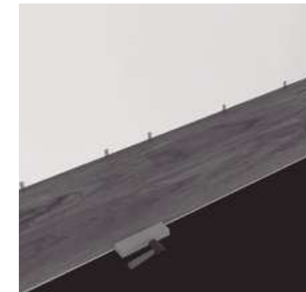
Paso 9: Después de 2-3 filas. Ajuste la distancia a la pared frontal colocando espaciadores de 3/8" (9,525 mm) en las paredes laterales y la pared del extremo. Una vez que el ajuste se realiza contra la pared principal, continúe instalando hasta la última fila.
