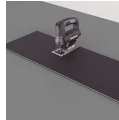
Paso 5: Corte con una sierra de calar, sierra de mano, sierra de corte o cortador de guillotina. Luego, rompa el piso, de manera similar a los paneles de yeso.
